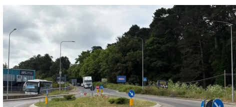
Nuovo impianto - Rotonda Quartiere Botte
