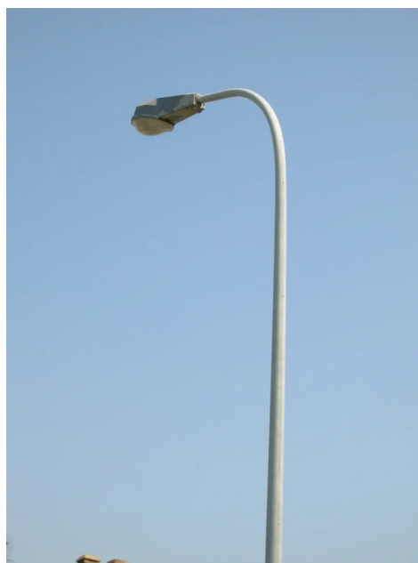
Punti luce stradali preesistenti1
