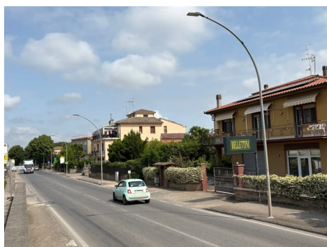
Nuovo impianto-SS.2 Cassia
